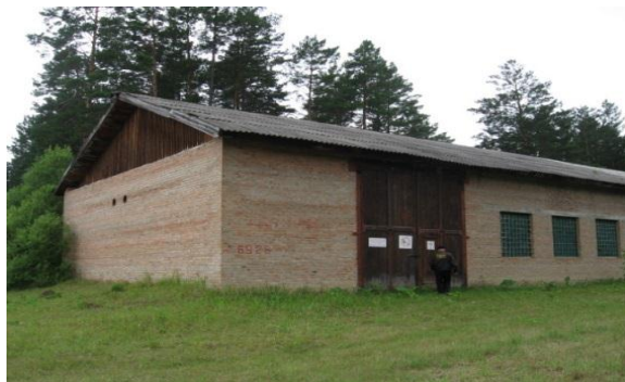
Здание стоянки механизмов
