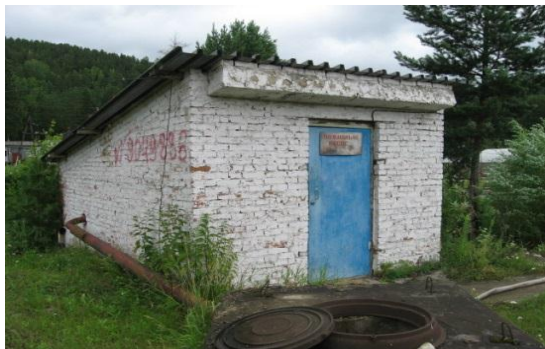
Здание насосной станции
