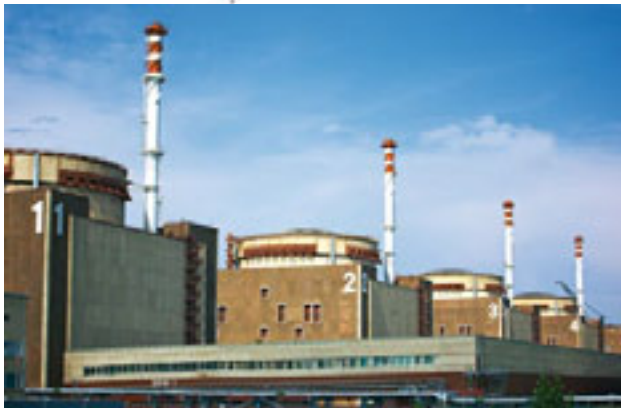
Общий вид АЭС: Балаковская (видны 4 блока)
